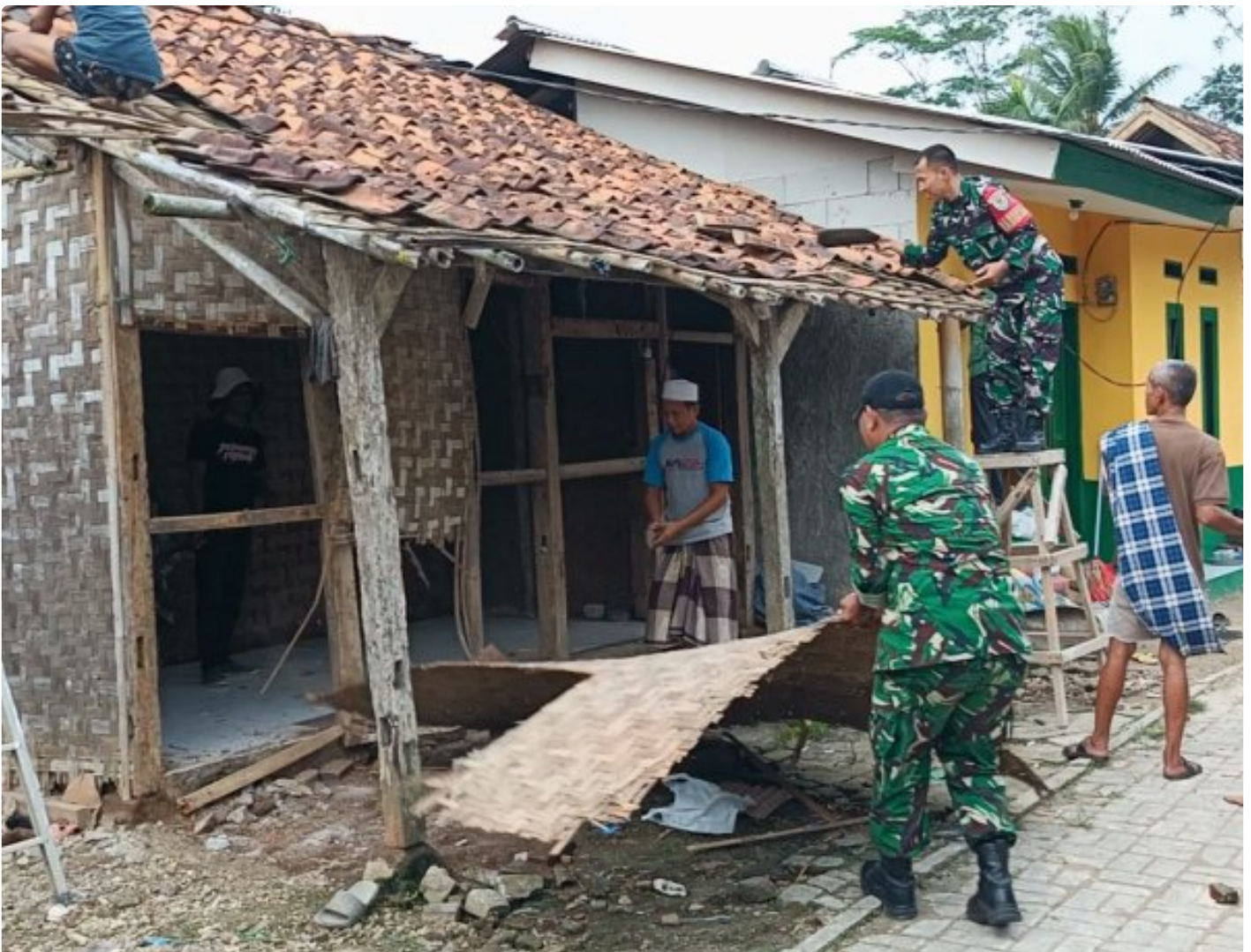
Pembongkaran Rumah Bapak Narmin
