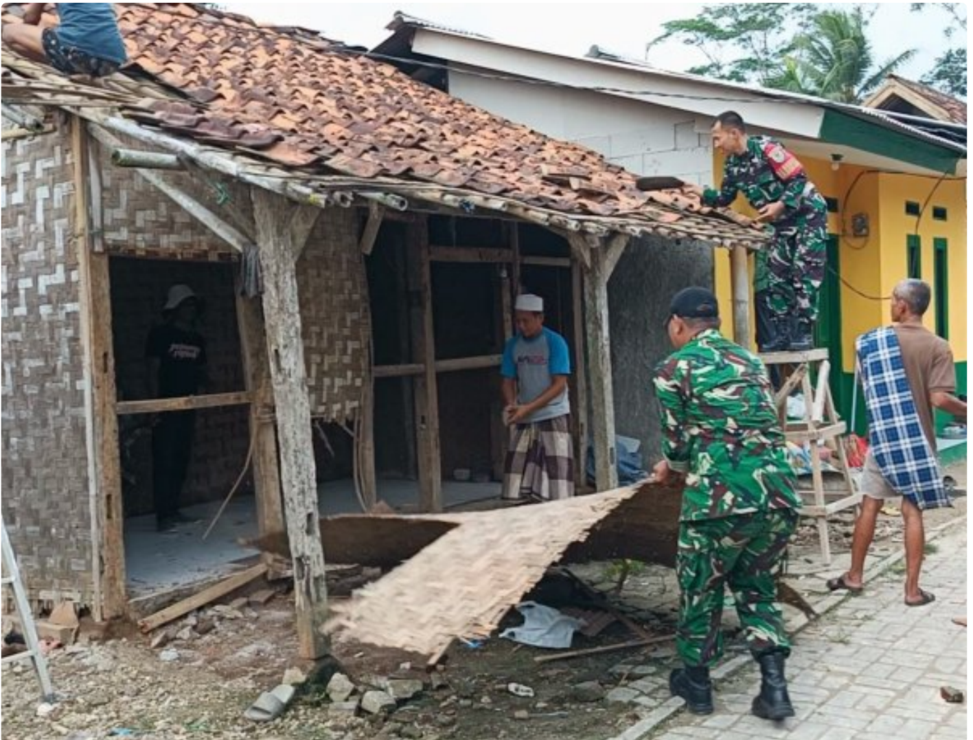
Pembongkaran Rumah Bapak Narmin
